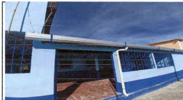
Sustitución de canal de metal
